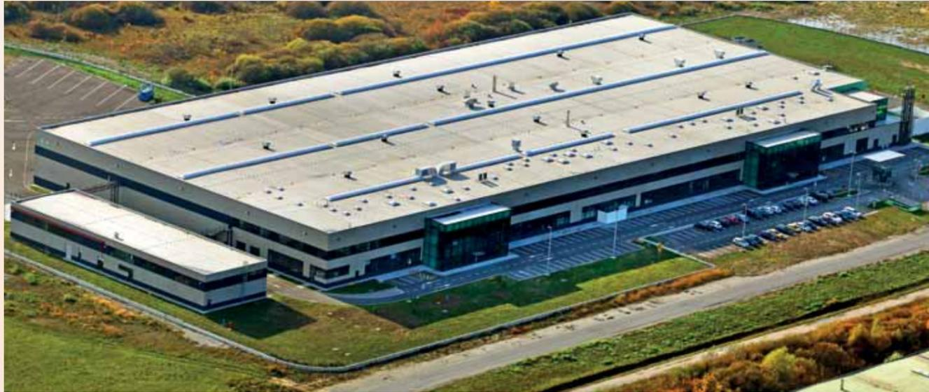
Proizvodno poslovna građevina Radin izgrađena je u Sv. Nedelji do potpune funkcionalnosti sa svim građevinsko-obrtničko-inštalaterskim radovima, te uređenjem okoliša. Ukupno je izvedeno 13.300 m<sup>3</sup> nasipa, ugrađeno je 9.800 m<sup>3</sup> betona, 800 t armature, 5.4532,80 m<sup>2</sup> montažnih fasadnih elemenata, 19.816 m<sup>2</sup> armiranobetonskih montažnih elemenata, raspona konstrukcije 30 m, te 14.500 m<sup>2</sup> prometnih površina.
