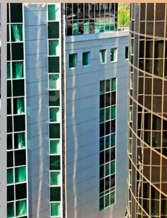
Izgradnja poslovno-trgovačkog kompleks Almeria sastoji se od A, B, C i D faze izgradnje. Građevina je građena na klasičan način, te je ugrađeno 35.000 m<sup>3</sup> betona i 3.648 t armature, a fasada je staklena. U fazi A – ističe se toranj visine 58 m (prizemlje +14 katova), faza B je visine 34 m (prizemlje + 7 katova), faza C i D visine su 34 m (prizemlje + 7 katova).
